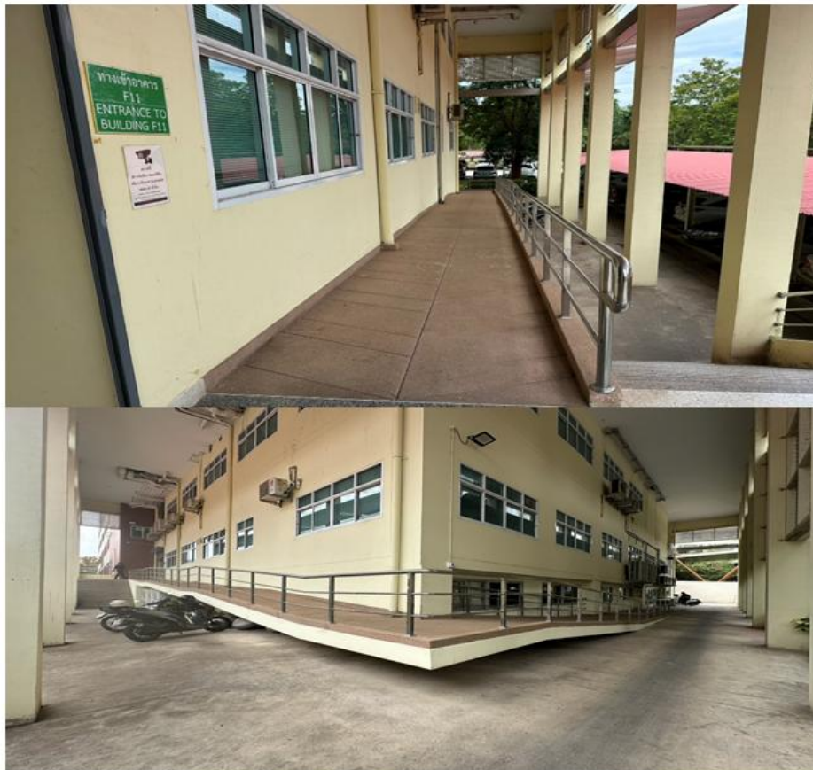
ทางลาด และเชื่อมทางเดินห้องน้ำ สะดวก
